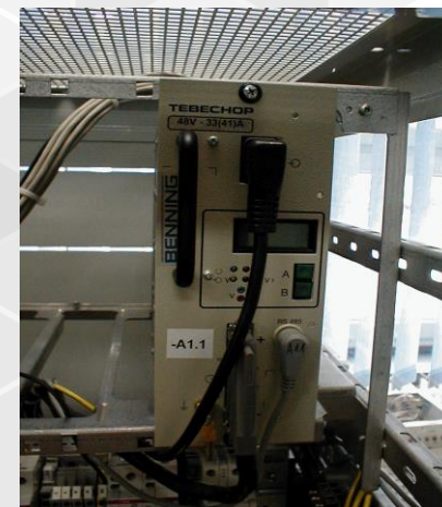
ISTOSMJERNI MODUL UPS-a
